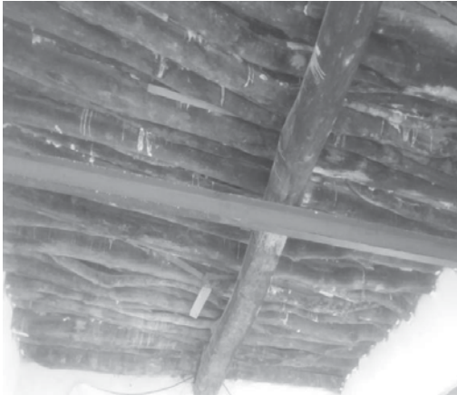
الصورة رقم (06) / سباط مسجد آمالو- سقف مسطح بخشب شجرة الصنوبر.
