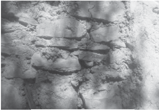
الصورة رقم (04) // سباط آمالو- طريقة المداميك المنتظمة
