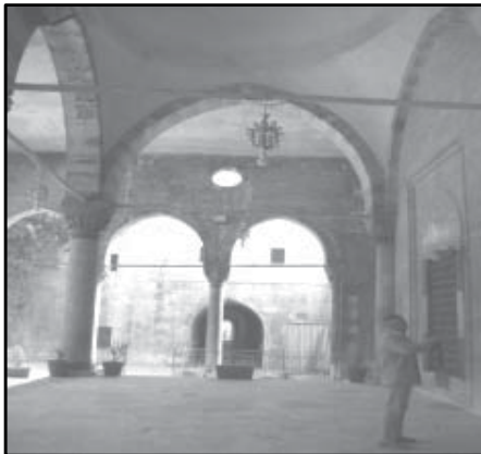
الصورة (٨) التسقيف بالقباب نصف الكروية في المجاز الأول من رواق قبلية جامع العادلية (من عمل الباحثة)
