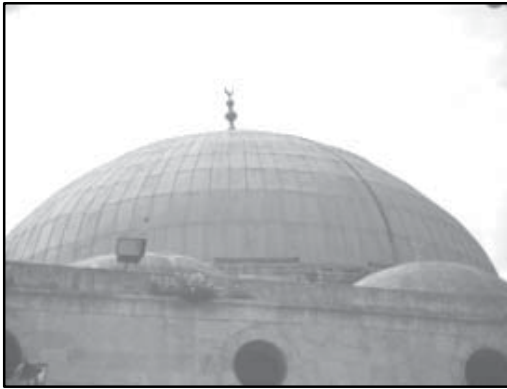
الصورة (٦) قبة جامع العادلية تغطي قبلية الصلاة يحيطها ستة عشر بروراً، وتبدو العناصر الداعمة لمقاومة الدفع الأفقي (من عمل الباحثة)
