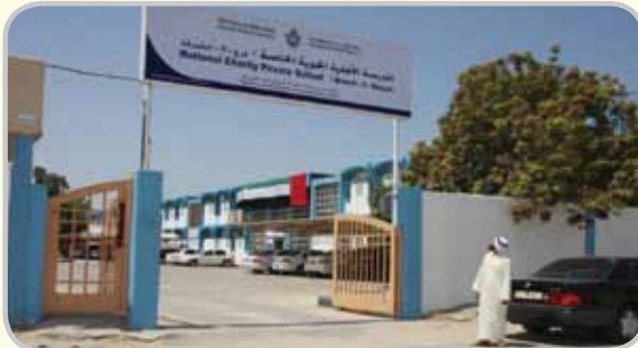
مبنى المدرسة من الخارج
